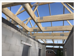
Der Dachstuhl beim Bauvorhaben in Babenhausen ist gerichtet
