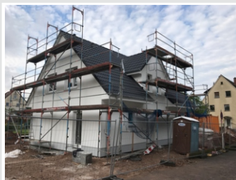
In Klingenberg zieht unsere Baufamilie schon bald ein.
