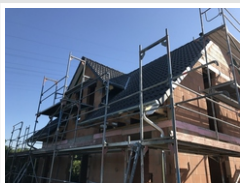
In Karlstein sind die Ausbaugewerke in vollem Gange
